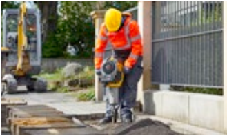
Tecnica di demolizione
