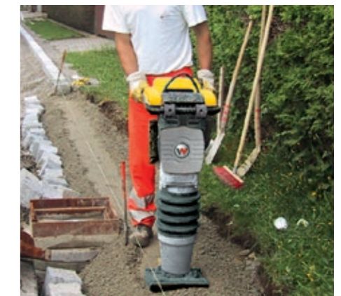
Přesné vedení stroje – důležité při hutnění v oblastech kolem okrajů.
