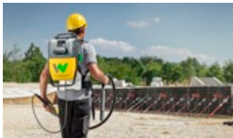
Technika na úpravu betonu
