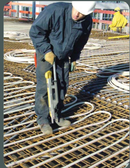
Régulation de la température du béton
