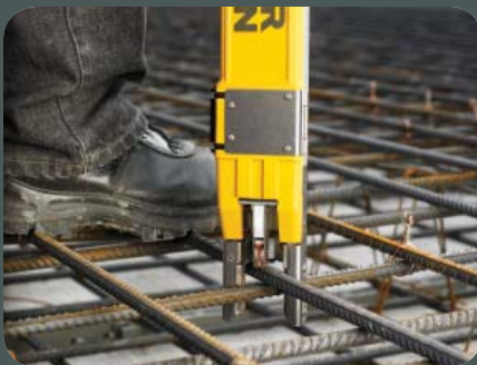
Mise en place
