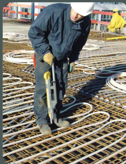
Regulación de la temperatura del núcleo de hormigón
